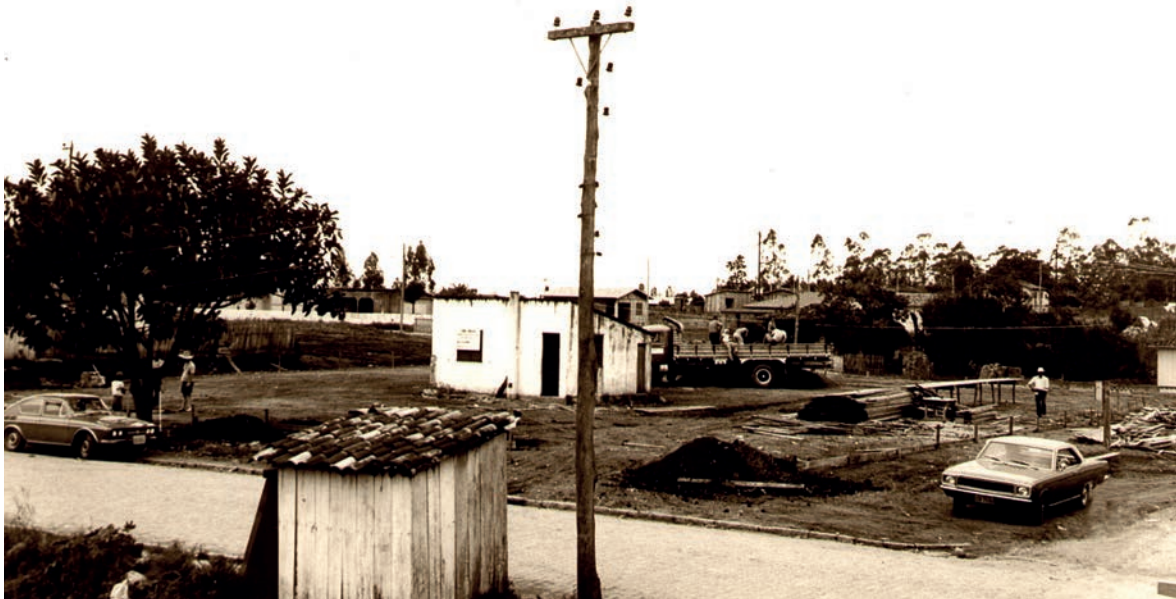
Início da construção do primeiro depósito da firma, em Içara.
